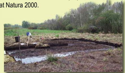
Décapage (Tourbière de Ligné)
