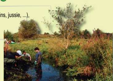
Chantier d'arrachage de la jussie
