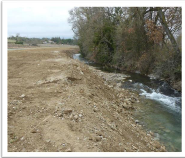
Figure 11 : la rivière avant travaux
