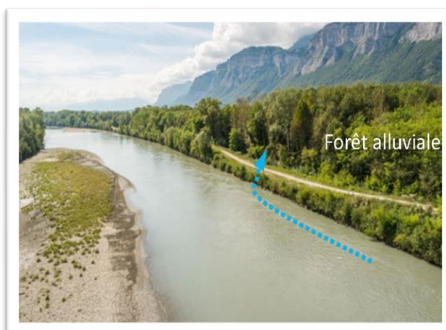
Figure 2 : restauration de la dynamique latérale à long terme - connexion de la forêt alluviale de l'Isère par effacement ponctuel des digues historiques © SYMBHI
