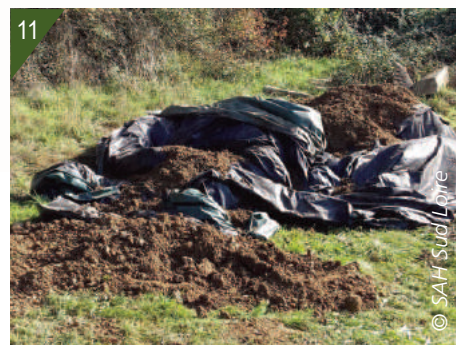
11 - Zone de dépôts des déchets protégés par un bâche.
