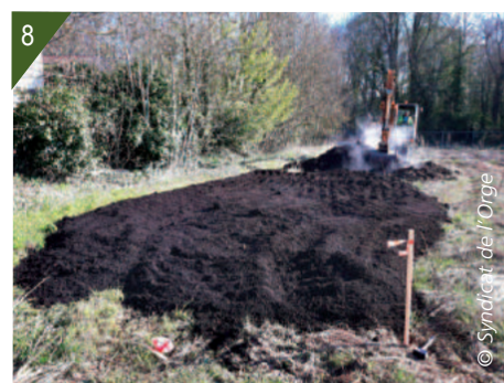
Épandage du compost de renouées. 7 - Compost étalé à même le sol. 8 - Compost intégré à la terre.
