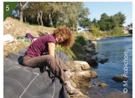
5 - Mise en place de la bâche.
