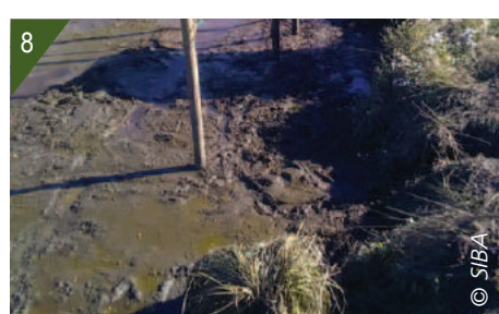
3 - Mise en place du barrage filtrant. 4 et 5 - Arrachage manuel de la jussie dans la darse. 6 - Le tractopelle manipulé depuis la berge. 7 - Herbier de jussie à marée basse. 8 - Herbier de jussie après interventions d'arrachage.
