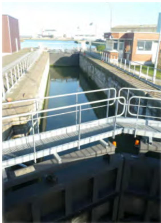
Figure 26 - Écluse de la Batellerie - Calais (source : Cerema)
