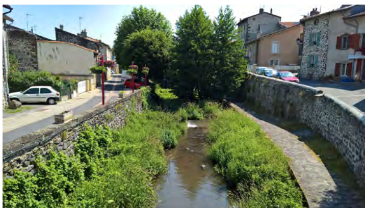
Figure 15 - Vue sur le Dolaizon depuis le « quai du Dolaizon », commune de Vals-près-le-Puy (source : Cerema)
