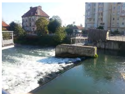
Figure 22 - Ouvrages sur la Seine à Troyes (source : Cerema)
