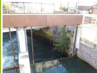
Figure 23 - Ouvrage de répartition des débits sur la Seine à Troyes (source : Cerema)
