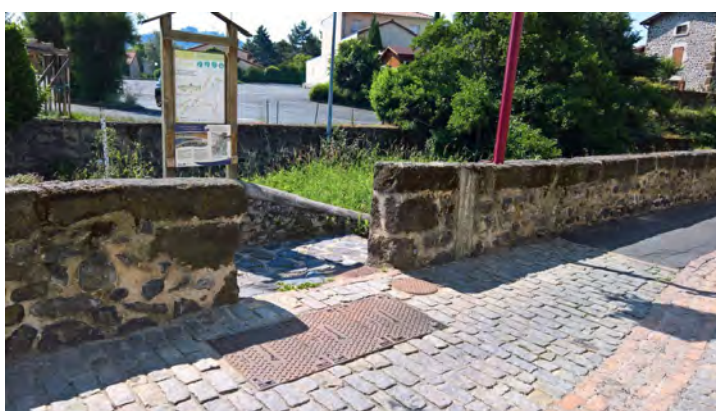
Figure 16 - Ouvertures non batardables, quai du Dolaizon (source : Cerema)
