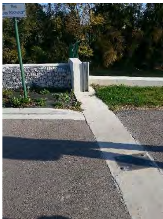
Figure 18 - Digue de Foicy sur la Seine à Troyes (source : Cerema)
