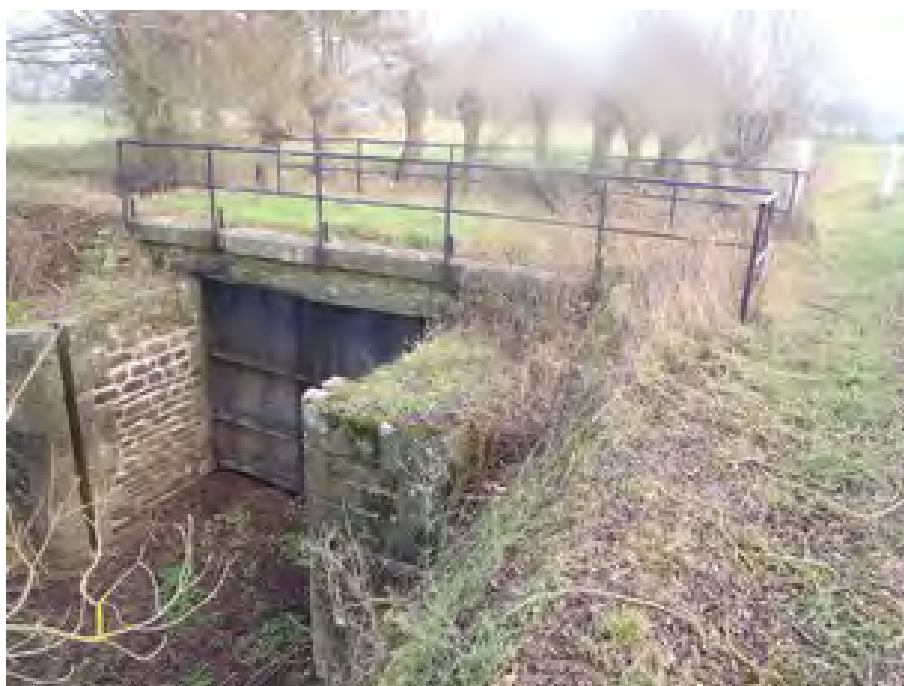
Figure 19 - Digue de Chalennes-sur-Loire (source : Cerema)
