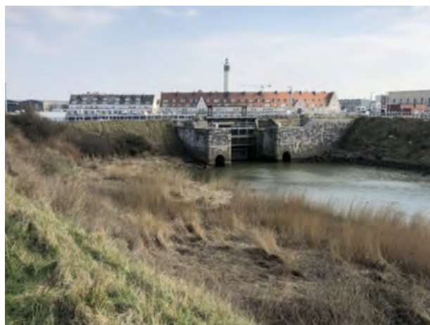
Figure 27 - Porte des 10 m et bassin des chasses à Calais (source : Cerema)
