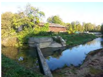
Figure 21 - Ouvrages du canal de Labourat à Troyes (source : Cerema)
