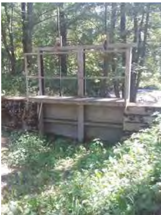
Figure 17 - Digue de Savignac sur l'Ariège (source : Cerema)
