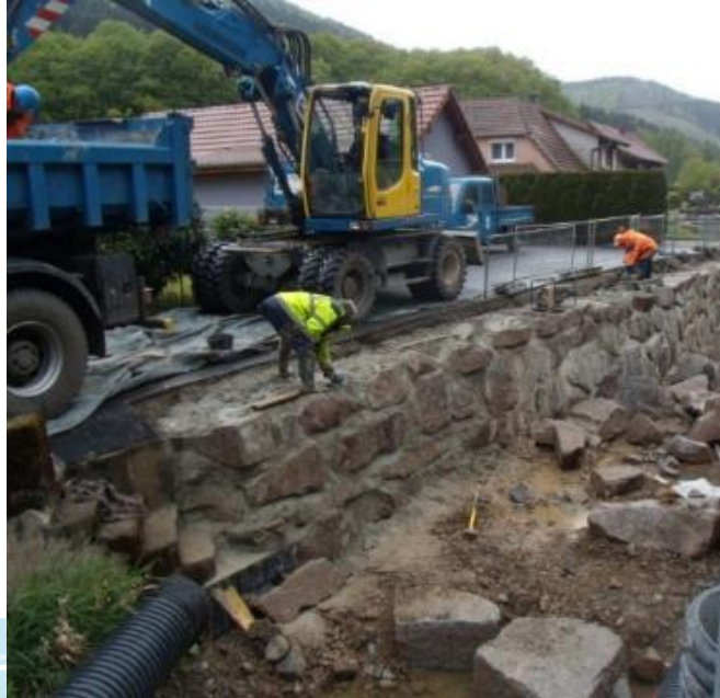
TRAVAUX SUR OUVRAGES EXISTANTS
