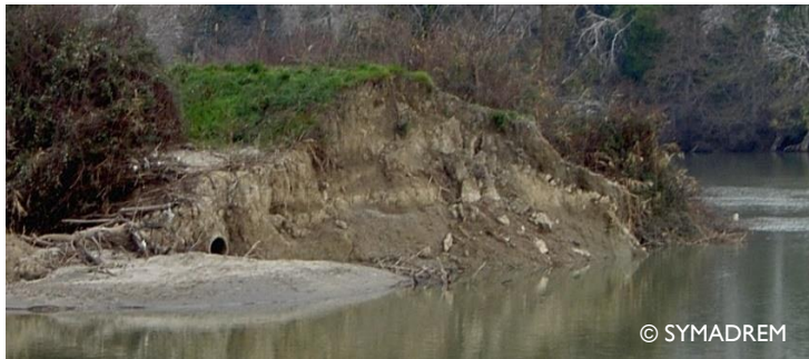
Surverse, mais érosion interne n'est pas écartée
