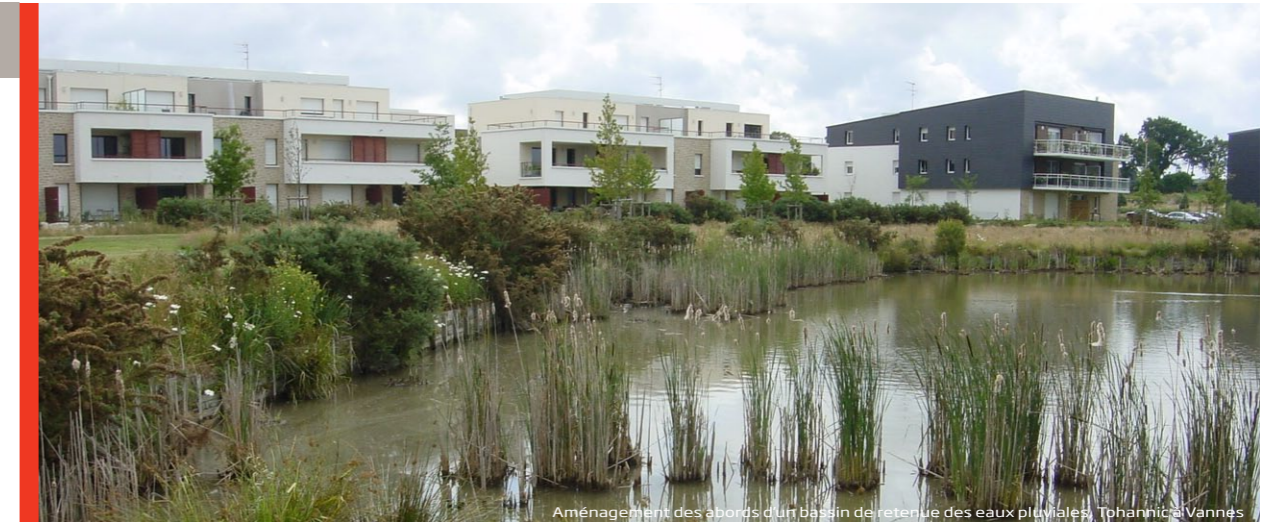
Aménagement des abords d'un bassin de retenue des eaux pluviales, Tihannic à Vannes
