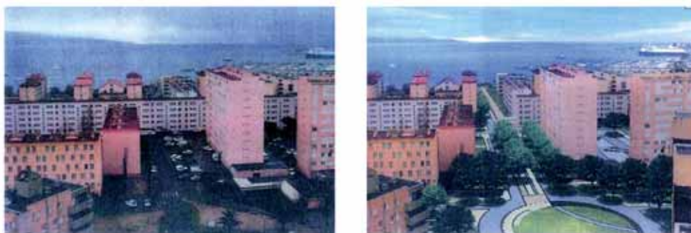
La seule démolition prévue à Ajaccio : le percement de la barre Mancini pour permettre l'évacuation rapide des inondations vers la mer.
