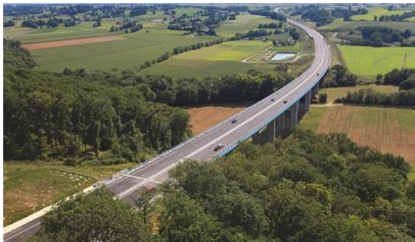
Photo 1: A65 Langon-Pau: le viaduc du Gabas.
