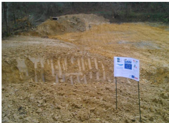
Effacement de l'ancienne dique et création de la nouvelle
