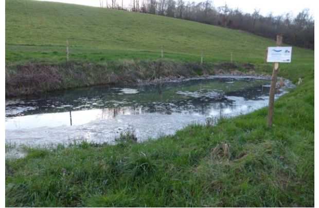
APRÈS LES TRAVAUX
