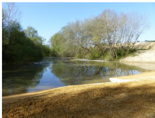
Etang après travaux (conservation des éléments boisés environnants)
