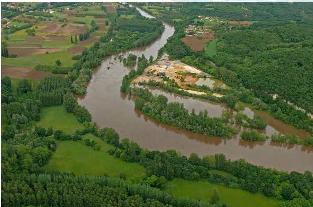
Avant travaux, un site de stockage et de concassage de granulats
