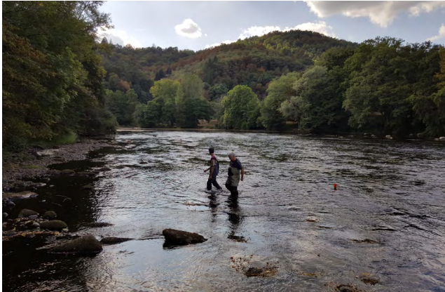
Avant travaux, un manque de sédiments grossiers indispensables à la reproduction des poissons migrateurs
