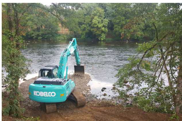
Aplanissement du substrat (régalage) après apports des granulats
