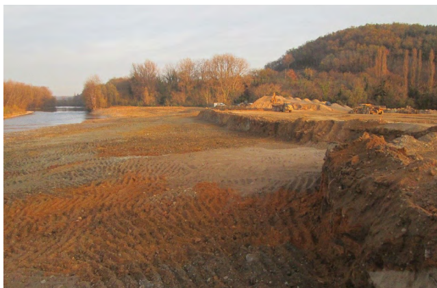
Site de Veyrignac pendant travaux
