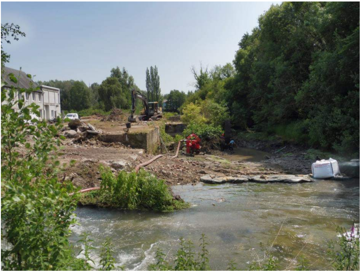
Vue aval du chantier
