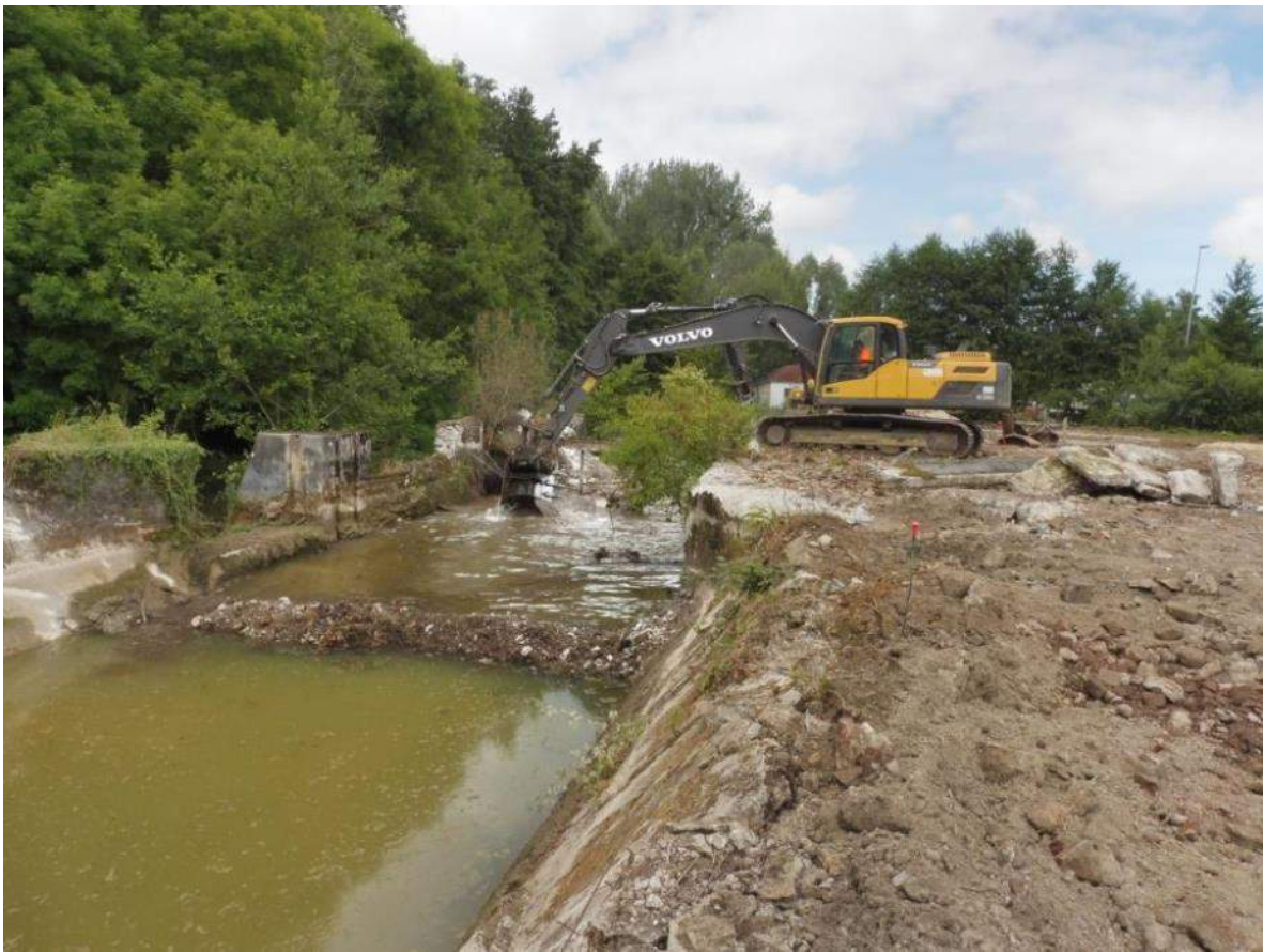
Démolition de l'ouvrage hydraulique
