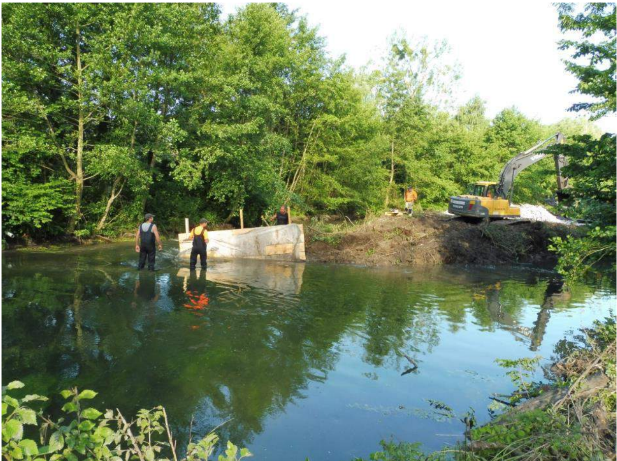
19/06 : Préparation de la mise en œuvre du batardeau (vue amont de l'île)
