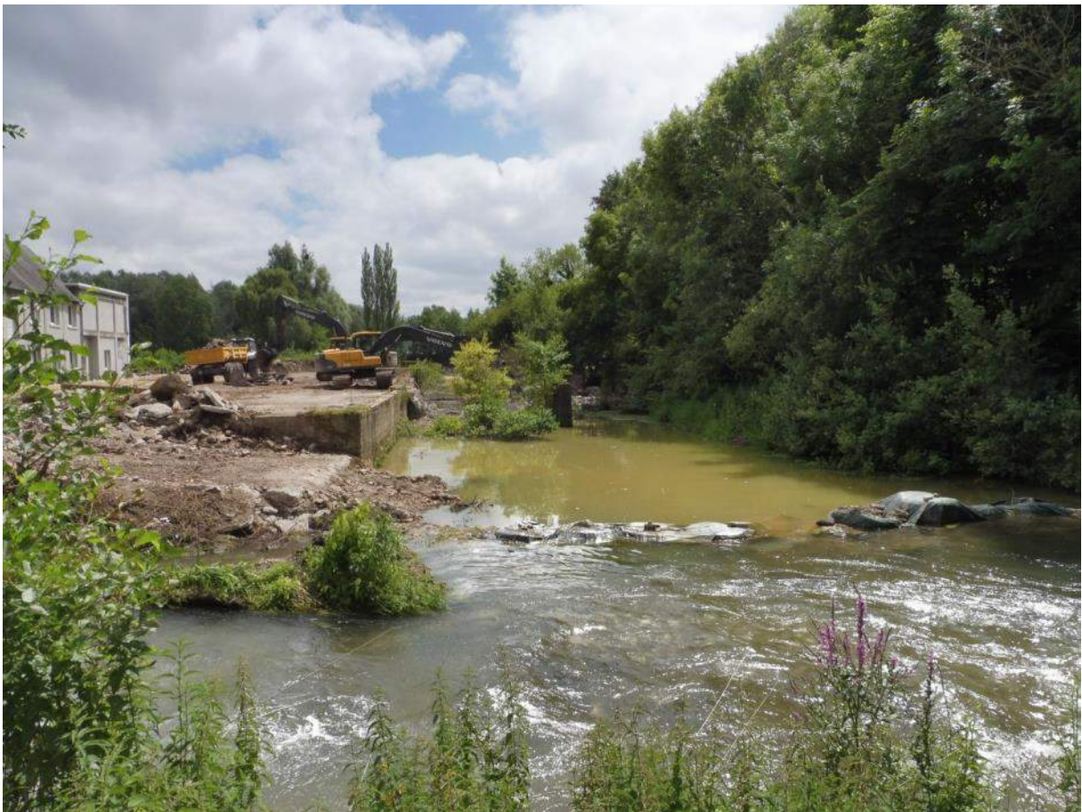
Vue aval en cours de démantèlement
