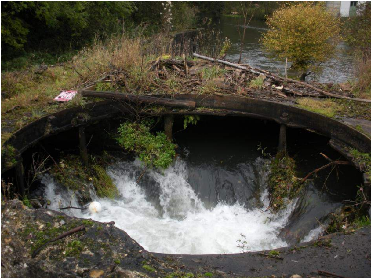
L'ancienne chambre de la turbine
