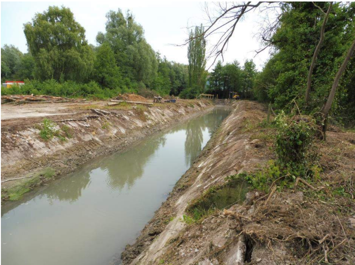
Mise à sec partielle du canal pour procéder à une pêche de sauvetage
