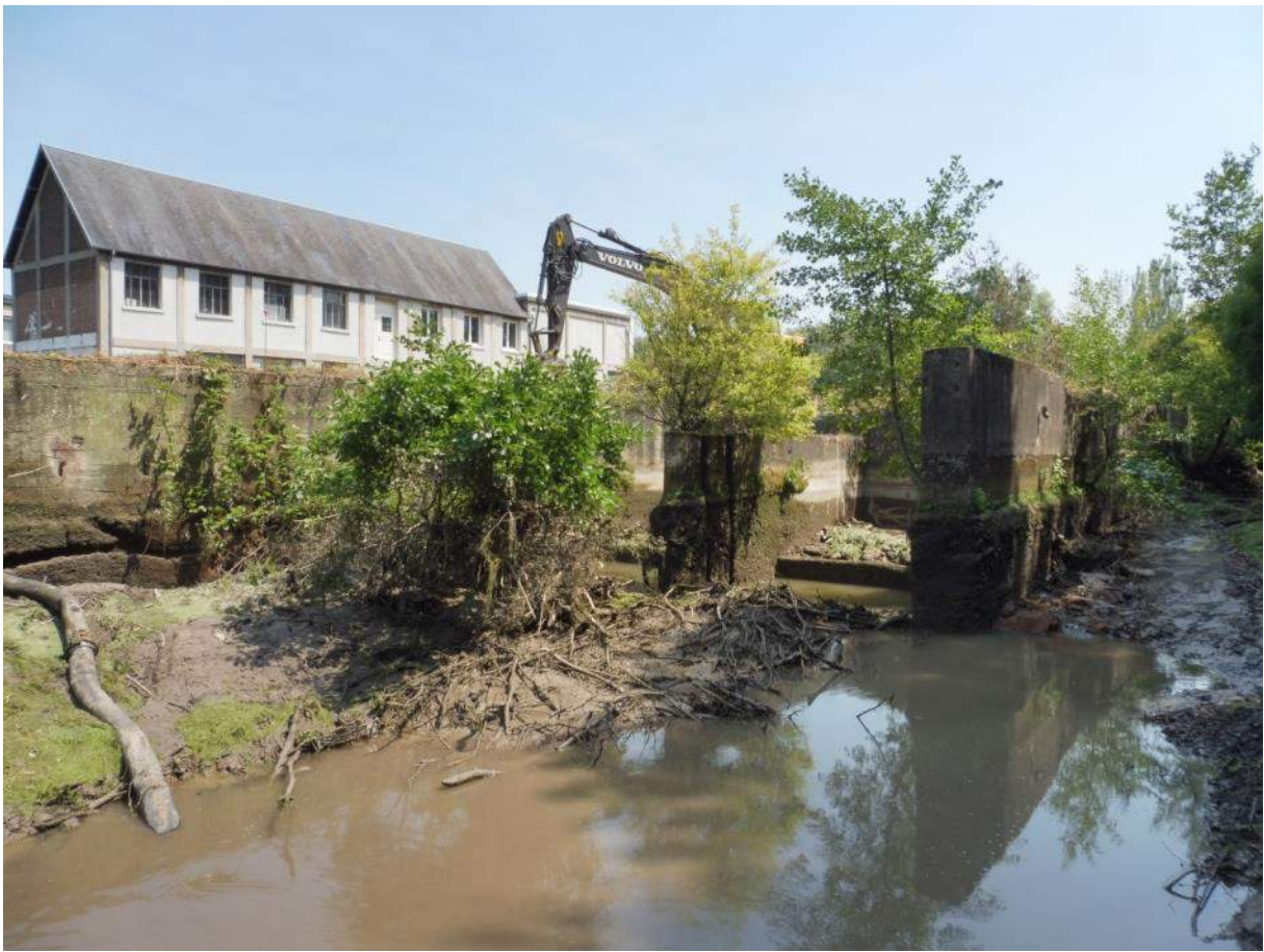
L'ouvrage quasiment hors d'eau
