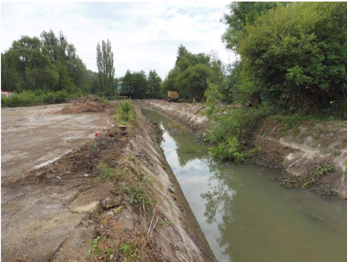
Le long canal bétonné à sec (ou presque)
