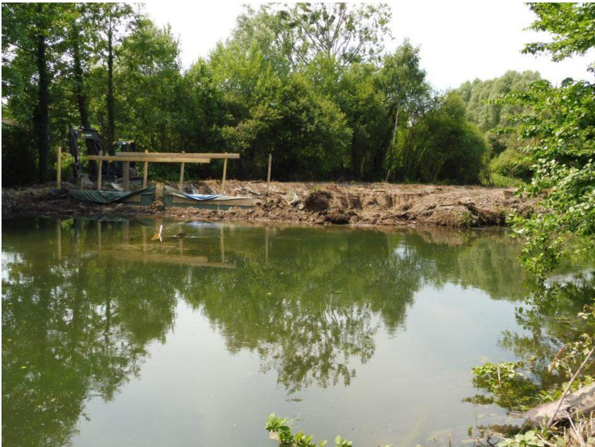
19/06 Finalisation du batardeau amont, l'ensemble des eaux est dérivé vers le bras droit
