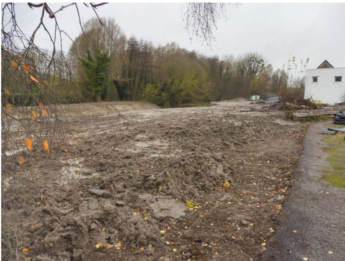
Décembre 2017 : Les travaux de terrassements sont arrêtés et ne reprendront que l'année suivante
