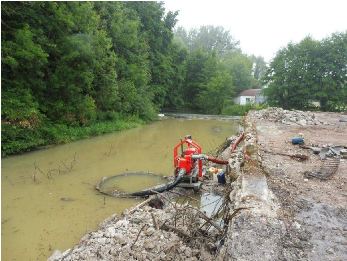
12/07 l'ouvrage est désormais complètement démolé (hormis enlèvement des ferrailles)
