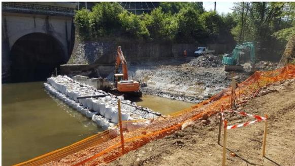
*Phase de démantèlement de la digue de la Broquerie, état du chantier au 4 juillet 2019*
