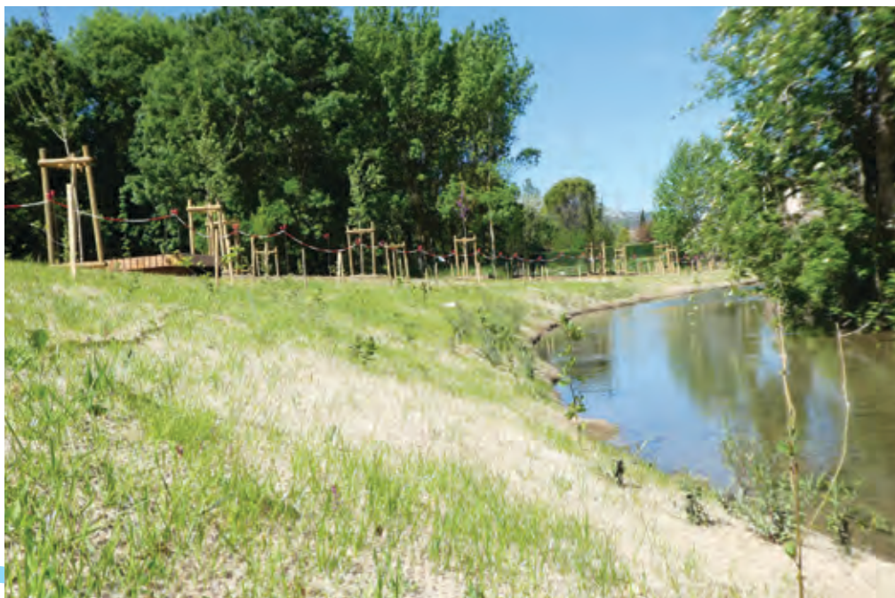
Aménagement des berges de l'Huveaune à Auriol (Juin 2019)
