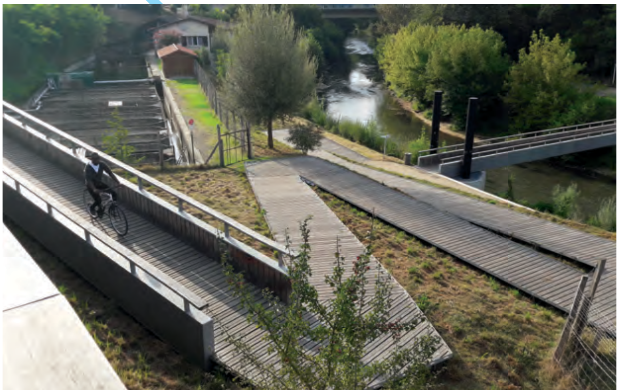
Passerelle sur les bords de la Midouze
