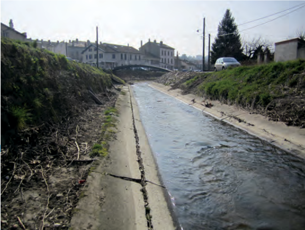
AVANT l'Yzeron canalisée en 2009
