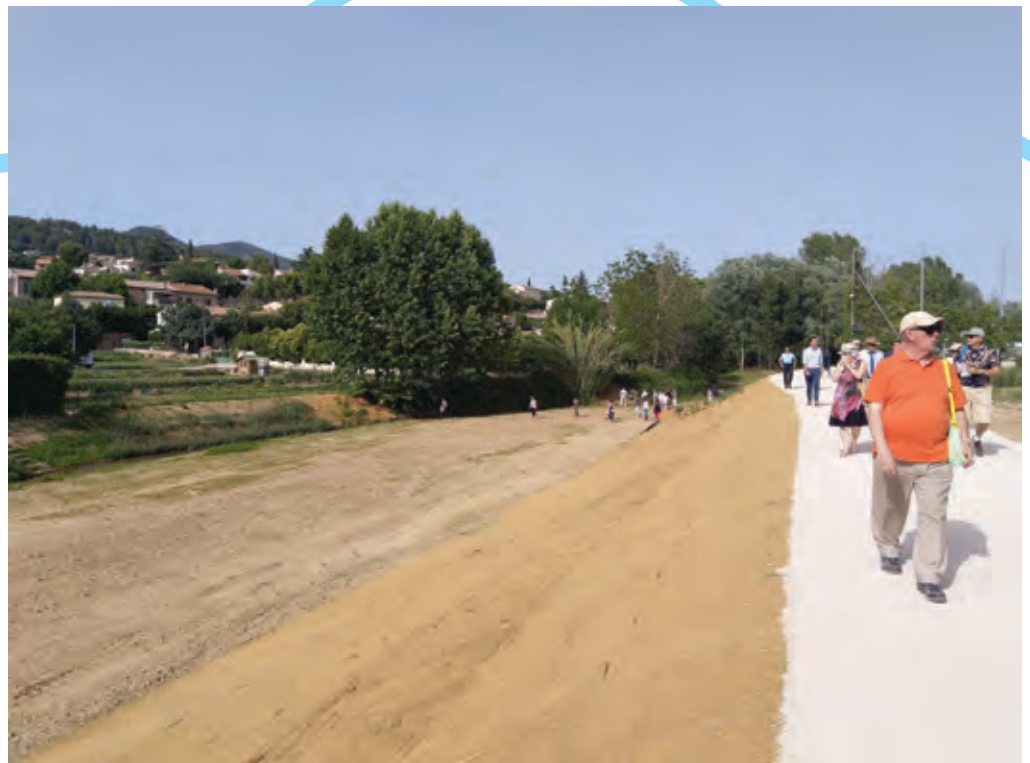
Aménagement de cheminements doux et berges restaurées (juin 2019)
