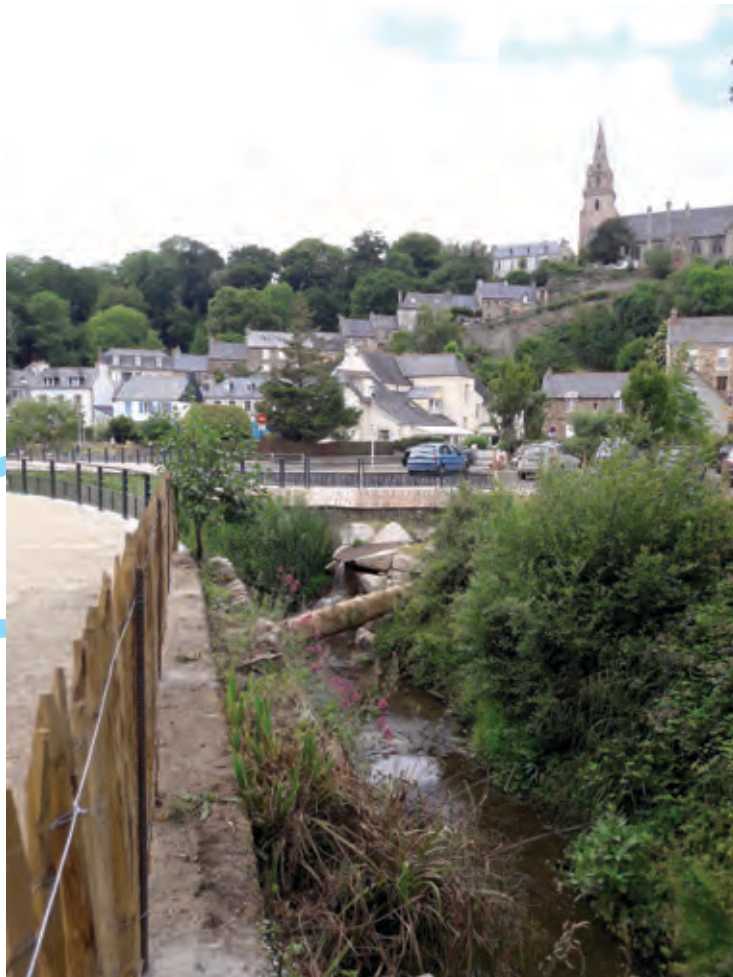
APRÈS Fin des travaux (Juin 2017)
