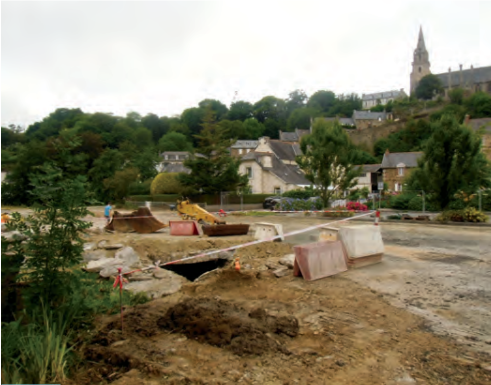
AVANT Début des travaux (Juillet 2016)
