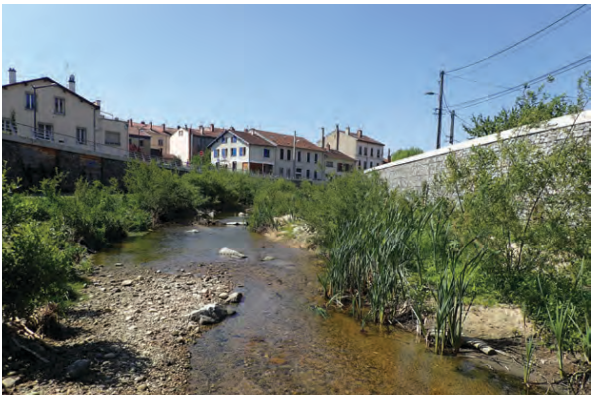
APRÈS Le lit du cours d'eau restauré en 2015
