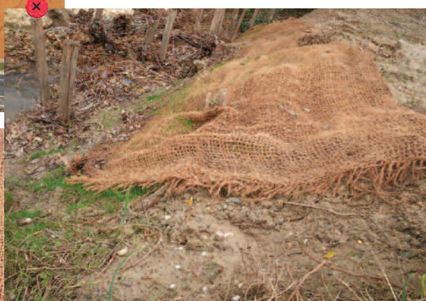
Ancrage insuffisant du filet en amont.
