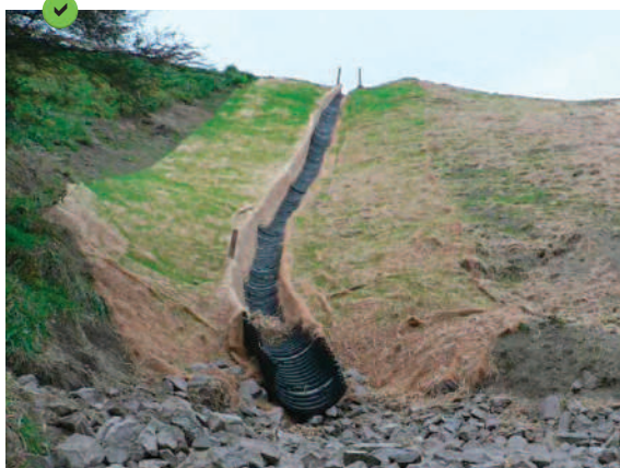
Demi-gaine HDPP sur une surface décapée mais ensemencée et paillée, avec équipement du point de rejet d'un dispositif anti-érosion.
