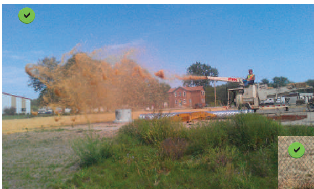
Exemple d'un paillage en cours.
