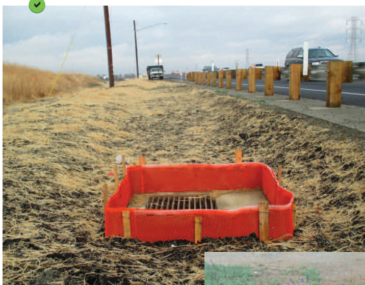
Type 1 : barrière périphérique en toile de géotextile tendue et associée à un paillage du fossé collecteur.
