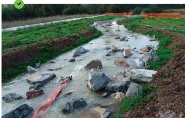
Rejet temporaire au sein d'une dérivation provisoire équipée de blocs dissipant l'énergie hydraulique.
