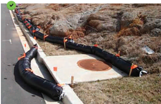
Type 4 : diversion en place pour éviter que l'eau chargée ne rentre dans l'avaloir.
