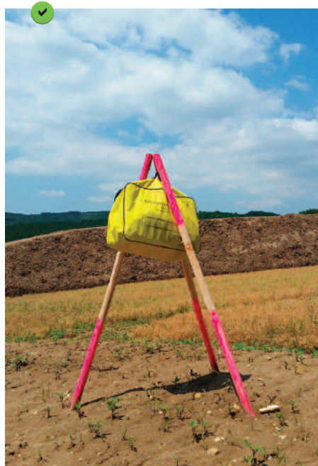
Exemple d'un kit anti-pollution isolé du sol.
