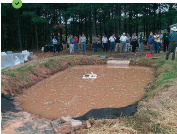
Piège à sédiments avec berges végétalisées.
