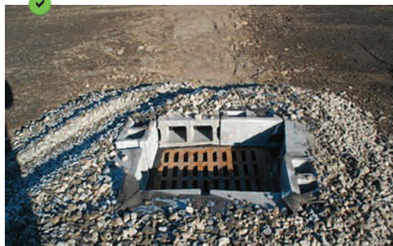
Type 3 : enrochement drainant qui permet une rétention de l'eau chargée et un écoulement réduit dans le réseau. Les deux dispositifs sont construits avec parpaings à l'intérieur et un merlon en graviers autour.
