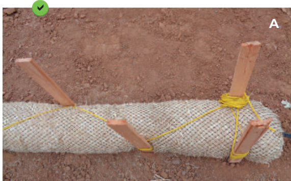
Boudins avec maillage plastique et rembourrage en fibre de paille, ancrés par pieux alternés (A) ou selon la technique "vampire" (B).
