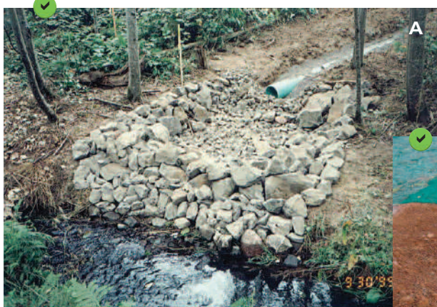
A, B, C - Dispositifs temporaires de protection des points de rejet à l'aide de tas de graviers et de blocs installés en amont du lit mouillé des cours d'eau. Attention toutefois à ne pas dégrader les berges.
