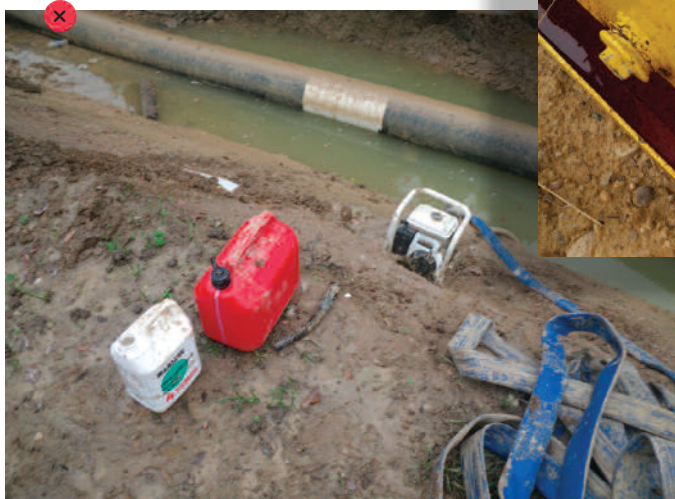
Stockage de bidons proches du milieu aquatique et groupe électrogène sans cuvette de rétention.
