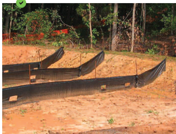
Fixation correcte des barrières géotextile.
