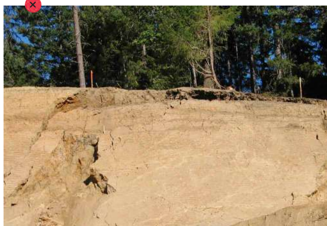
Glissement de terrain en cours.
