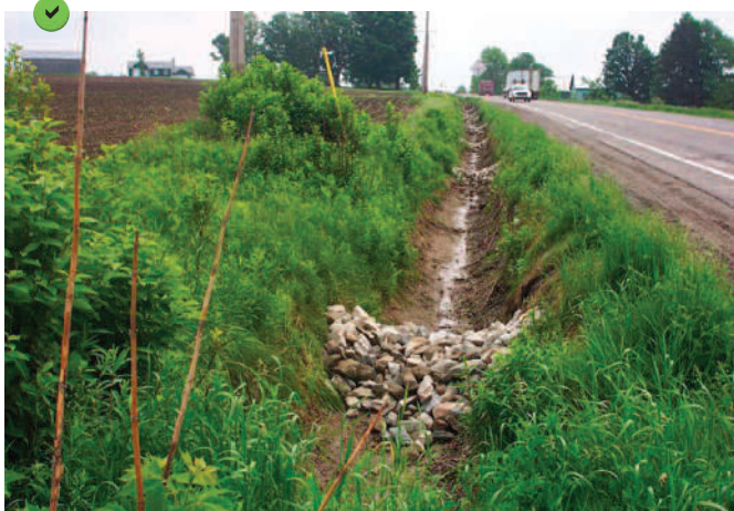
Fossé avec seuils en série.
