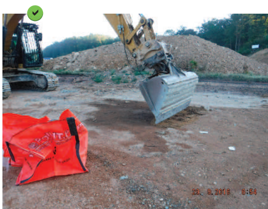
Exemple de la récupération de terres polluées aux hydrocarbures et de leur stockage dans un big bag étanche.
