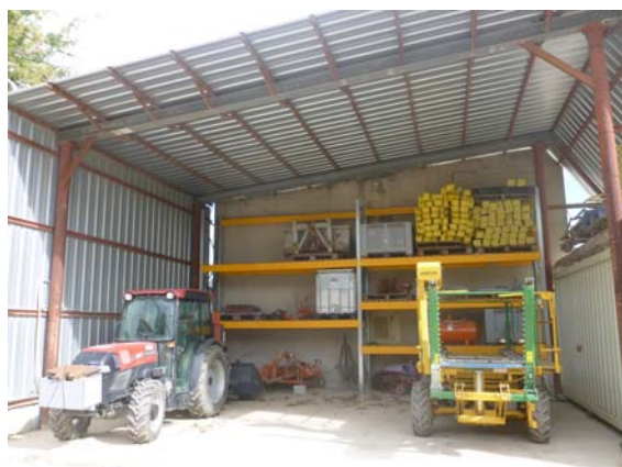
Photographie 3 : Installation d'étagères métalliques pour sécuriser le petit matériel par surélévation, Mondragon (Vaucluse) - Source: DREAL Rhône-Alpes/Mission Rhône
