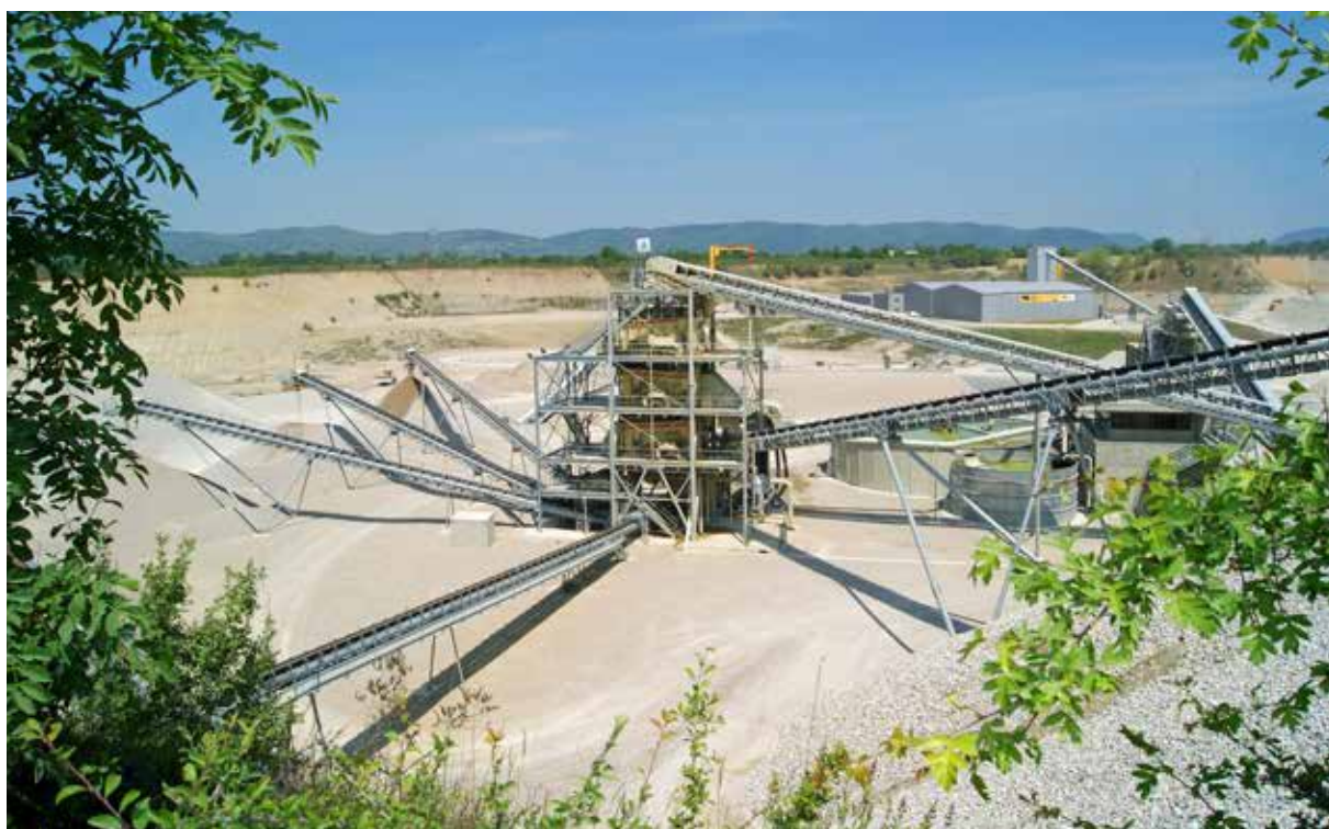
Installations de traitement
