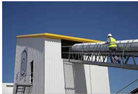
Capotage des tapis et bardage des installations
