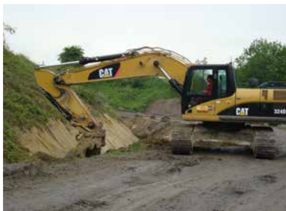
Aménagement d'un fossé pour favoriser la circulation des eaux de ruissellement
