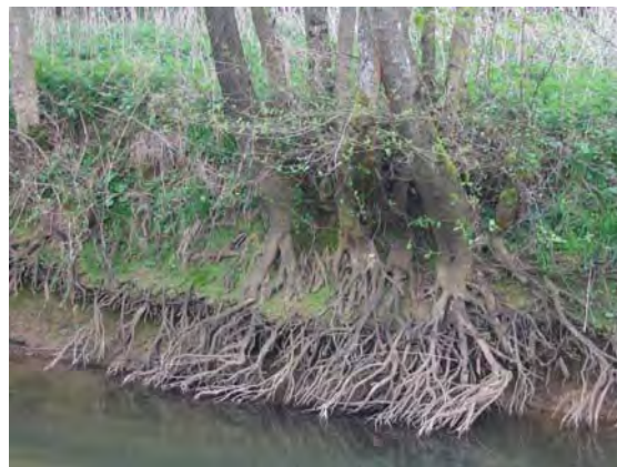
Figure 30 : Enfoncement du lit de la Vence à La Francheville (LE BRETON, 2004).
