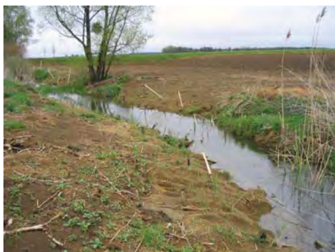
Photo 2 : Protection de berges retalutées sur le Moutru à Saint Hilaire en Woëvre (LE BRETON, 2004).
