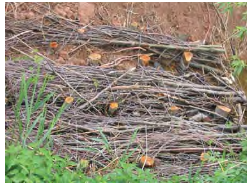
Figure 24 : Détail d'un des seuils en fagots réalisés sur la Schernetz à Epfig (LE BRETON, 2004).
