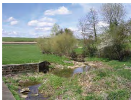
Photo 1 : Barrage de la prise d'eau du Moulin Froid à Blevaincourt (LE BRETON, 2004).
