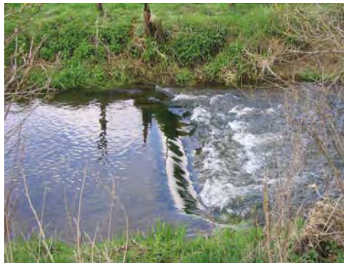
Figure 22 : Seuil sur l'Aroffe à Gibeauheim (LE BRETON, 2004).
