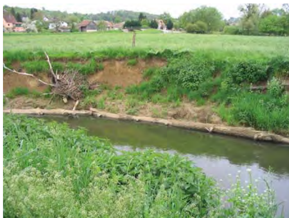
Photo 5 : Exemple de tunage accompagné d'un retalutage des berges (LE BRETON, 2004).
