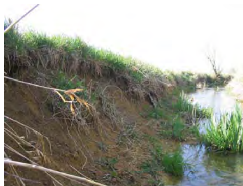
Photo 13 : Erosion de berge sur l'Yron à Sponville (LE BRETON, 2004).
