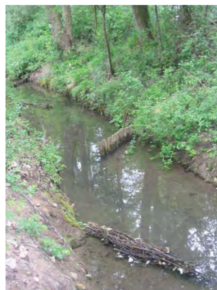
Figure 16 : Diversification du profil en travers du Neumattgraben à Krautergersheim (LE BRETON, 2004).
