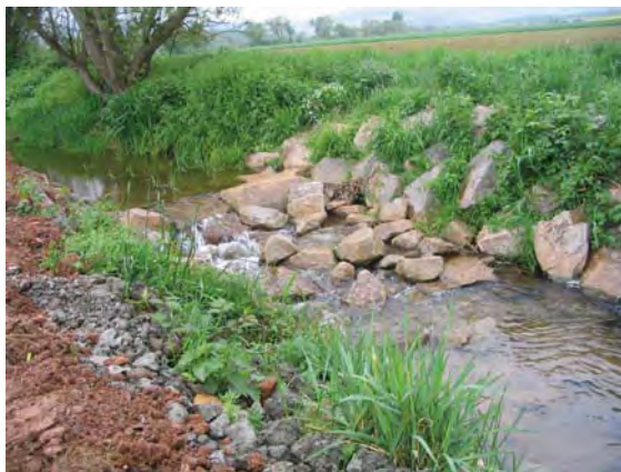
Photo 5 : Seuil en enrochement sur la Schernetz à Epfig (LE BRETON, 2004).
