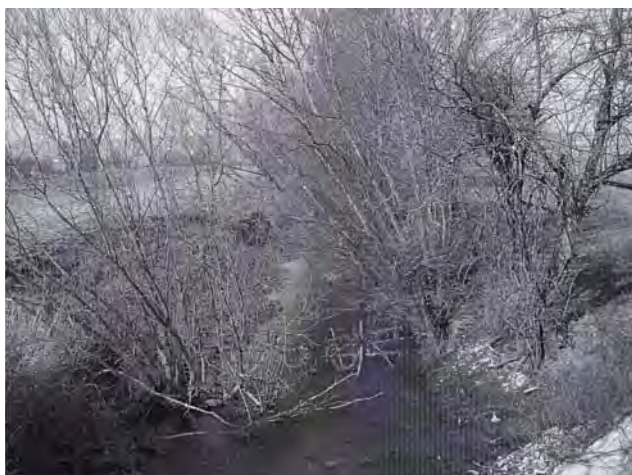
Photo 1 : Ruisseau dit du Canal Gendarme à La Cassine avant travaux (UDASA, 2003).
