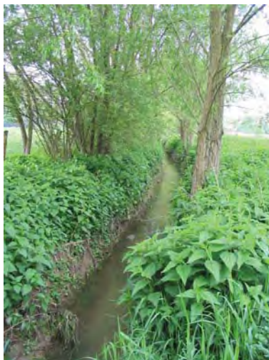
Photo 1 : Berges abruptes témoignant d'anciens curages sur le Billoneau à Ancemont (LE BRETON, 2004).
