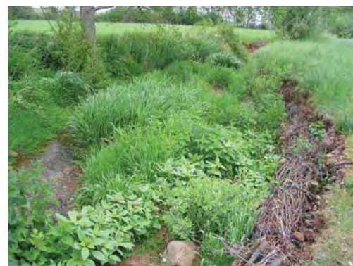
Photo 4 : Protection de berges par pose de fagots sur la Schernetz à Epfig (LE BRETON, 2004).
