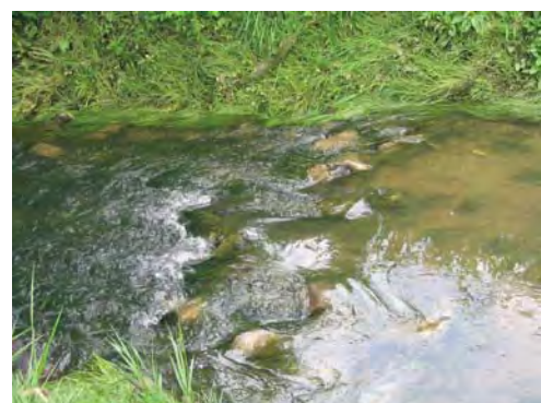
Figure 21 : Seuil en enrochement sur le Seltzbach à Kutzenhausen (LE BRETON, 2004).
