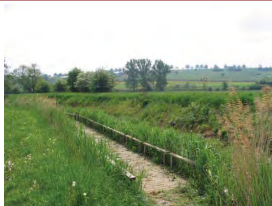
Photo 1 : Vue d'ensemble des berges retalutées du Seltzbach à Kutzenhausen (LE BRETON, 2004).
