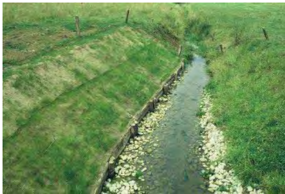
Photo 6 : Berge retalutée juste après les travaux sur l'Aroffe à Tramont-Emy (GOETGHEBEUR, 2000).
