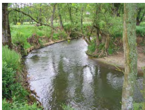
Figure 29 : Tunage pour fixer le lit de la Largue à Heidwiller (LE BRETON, 2004).
