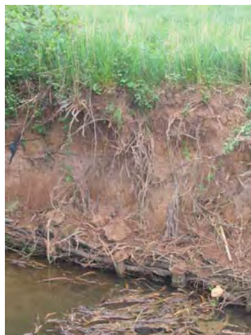
Photo 2 : Vue d'ensemble sur les protections de berge en tressage au pied des berges retalutées sur la Schernetz à Epfig (LE BRETON) 2004).
