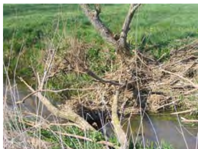
Photo 6 : Embâcle entravant fortement l'écoulement de l'Yron à Sponville (LE BRETON, 2004).
