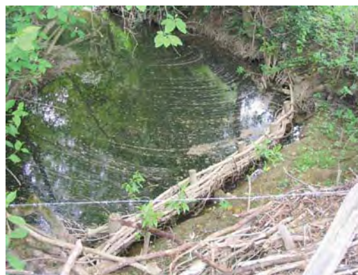
Photo 2 : Tressage sur le Traubach à Bretten (LE BRETON, 2004).
