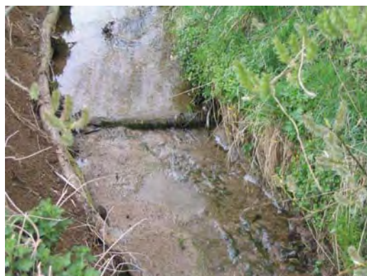
Photo 5 : Exemple d'un seuil sur le Dorfgraben à Duntzenheim (LE BRETON, 2004).
