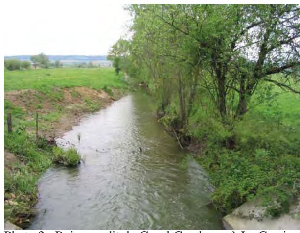
Photo 2 : Ruisseau dit du Canal Gendarme à La Cassine après travaux (LE BRETON, 2004).
