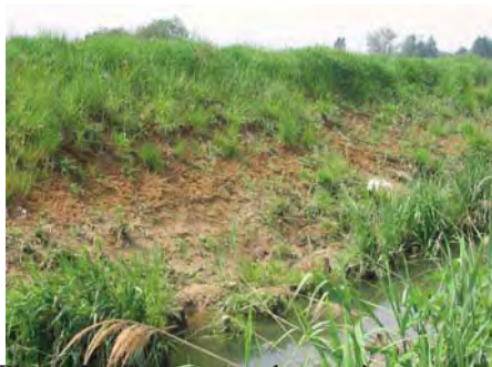
Photo 2 : Secteur aux berges à nu sur le Seltzbach à Kutzenhausen (LE BRETON, 2004).
