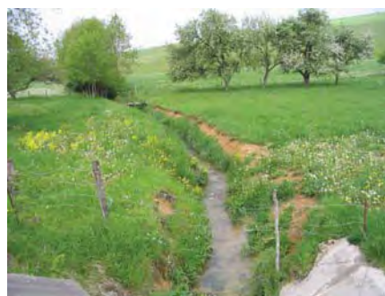
Photo 4 : Secteur dénudé induisant des érosions de berge sur le Billoneau à Ancemont « pont de la Morlette » (LE BRETON, 2004).
