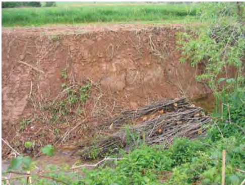
Figure 23 : Seuil en fagots sur la Schernetz à Epfig (LE BRETON, 2004).
