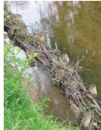
Fascines de saules sur l'Ehn à Niedernai (LE BRETON, 2004).
